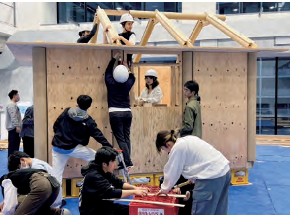
学生ボランティアによる紙管仮設住宅の建設作業の様子 © 坂茂建築設計
