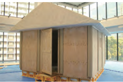
紙管仮設住宅の試作棟
