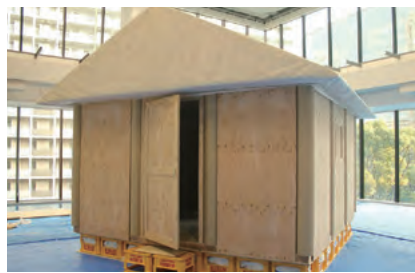
紙管仮設住宅の試作棟
