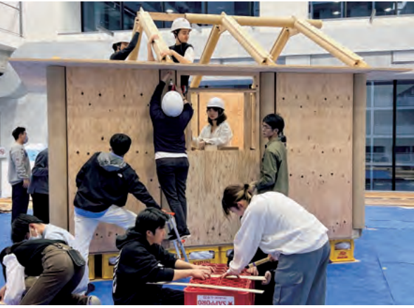
学生ボランティアによる紙管仮設住宅の建設作業の様子 © 坂茂建築設計
