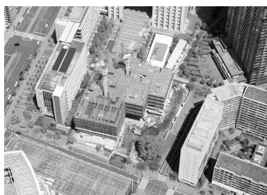
第二校舎工事風景
