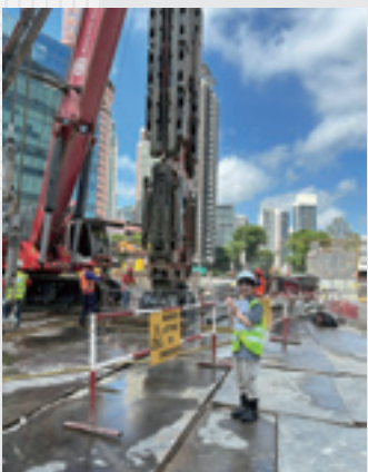
現場の掘削機が地面から出てきた瞬間
