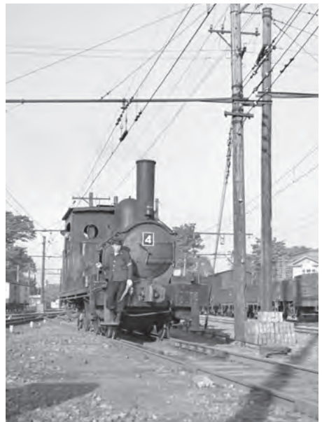
西武鉄道4号機関車として現役の頃の403号機関車
