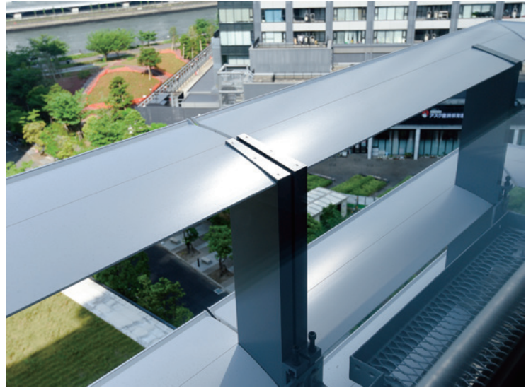
校舎全体をくぐるアルミルーバー
