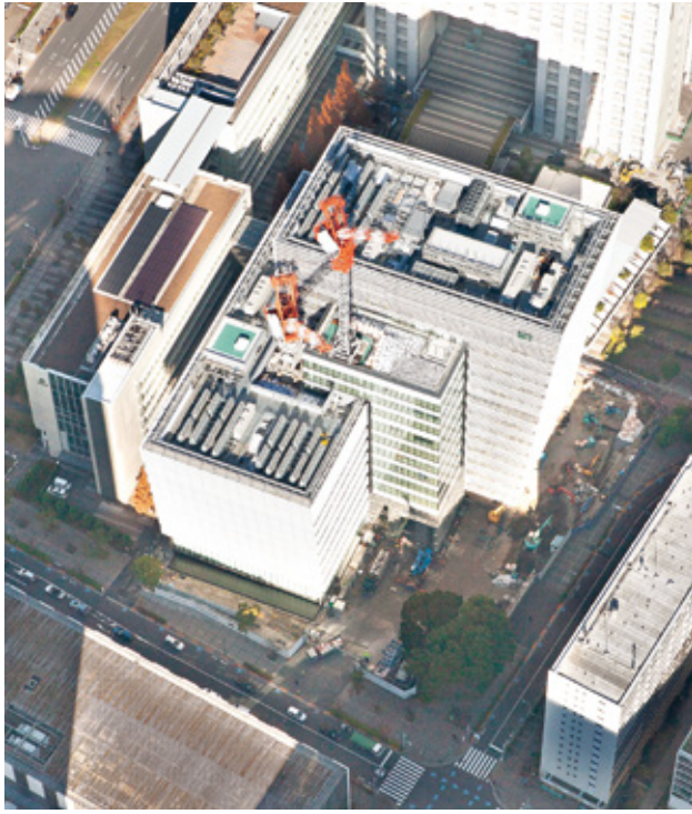
建設中の本部棟(2021年12月13日撮影)
