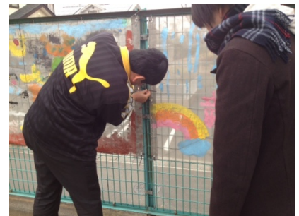
小学校の先生方と行う修繕作業
