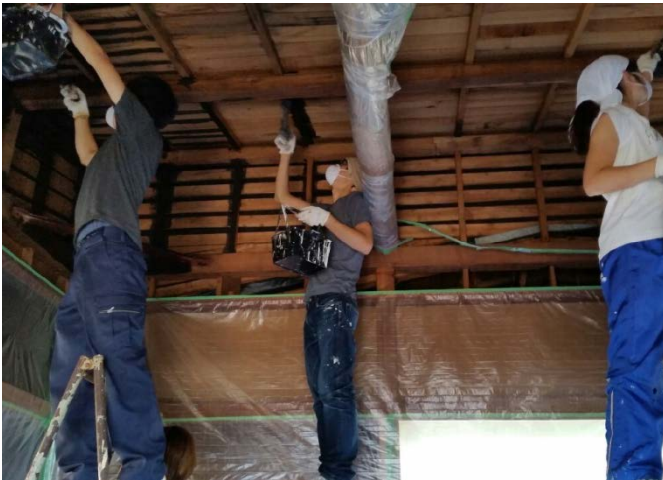
↑2 階天井裏の塗装
