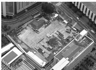
第二校舎工事風景
