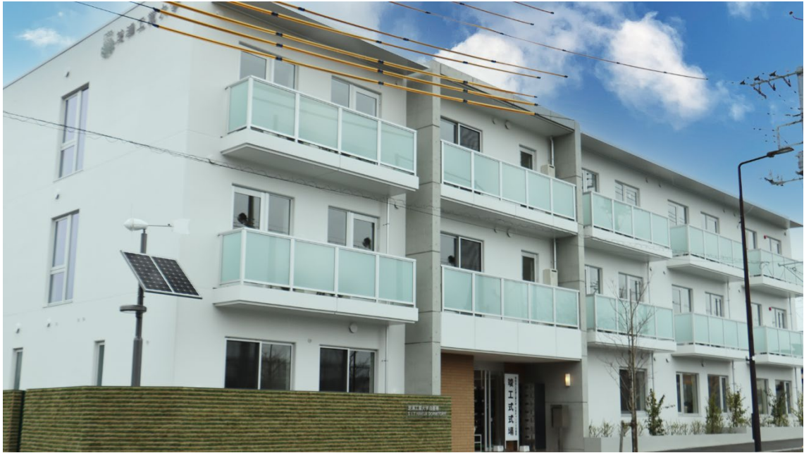
▲竣工した白亜寮
