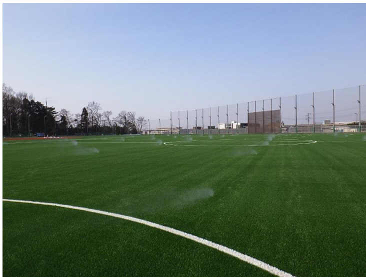
ミスト散布設備
