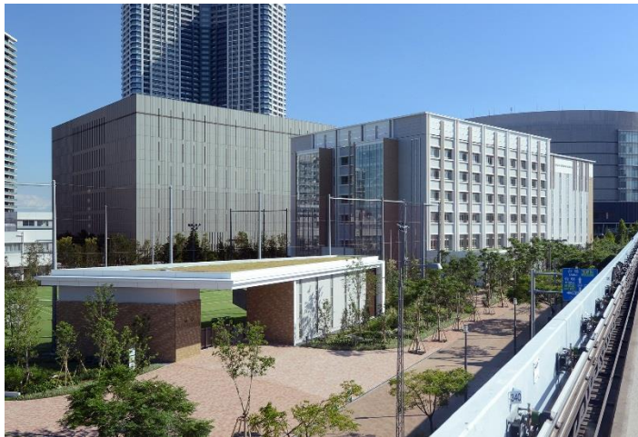
外観（ゲート棟から）
