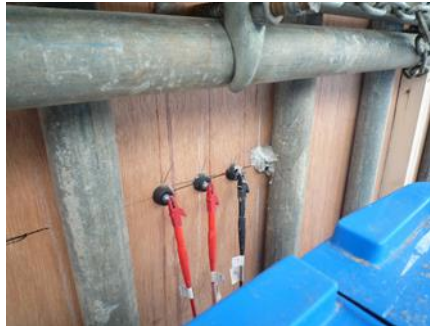
コンクリート中の電気抵抗値を測定する様子
