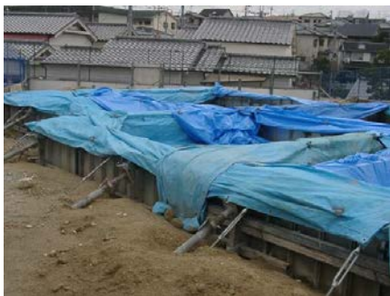
コンクリートを養生する様子
