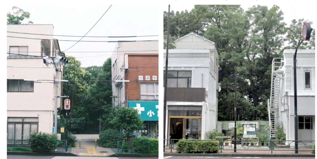
建物の取り壊しが行われた場所（2023-06/12 作者撮影）
