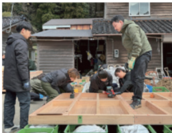
珠州市3月8日～11日にかけて仮設住宅(ペーパーログハウス)を建設
