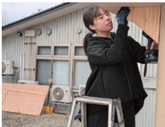
輪島市 3月8日～11日にかけて仮設工房を建設
