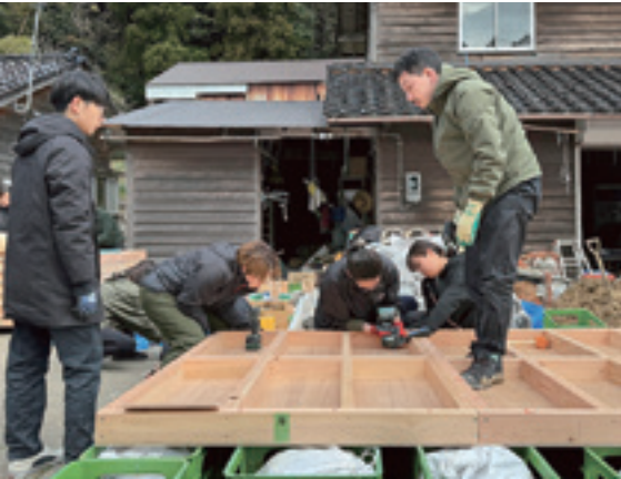
珠洲市3月8日~11日にかけて仮設住宅(ペーパーログハウス)を建設
