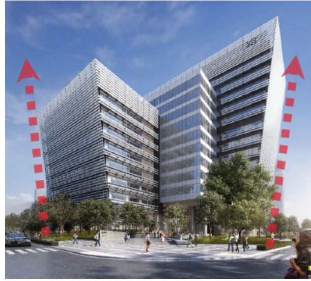
斜柱の鉛直面に対する傾斜角:約6° 傾斜による1階と10階での柱位置の差:約5m
