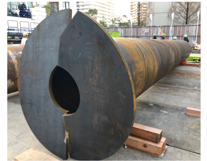
鋼管杭 先端翼開端部
