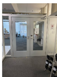
テクノプラザ 2 中の扉
