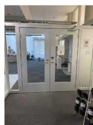
テクノプラザ 2 中の扉
