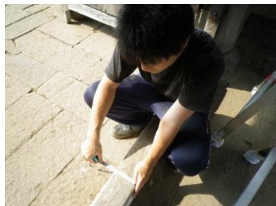
現地調査(実測作業)
