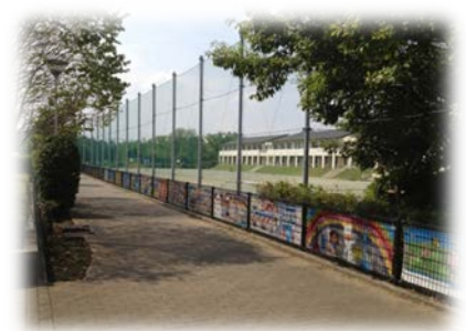
春野小学校フェンス
