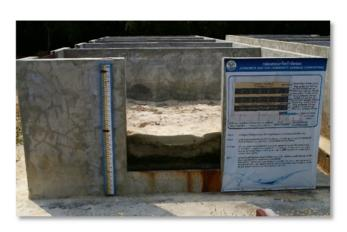
Concrete Box Technology はコンポストである.中はサンドイッチ構造で構成されており主に赤土と廃棄物 (主に野菜や果物の廃棄物,最大:660-670kg)が入っている.
