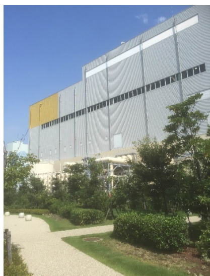
〔写真 5.1〕 磯子火力発電所
