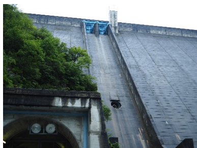
(写真 2.1) ダム本体(下面)
