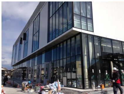
久ノ浜の防災センター
