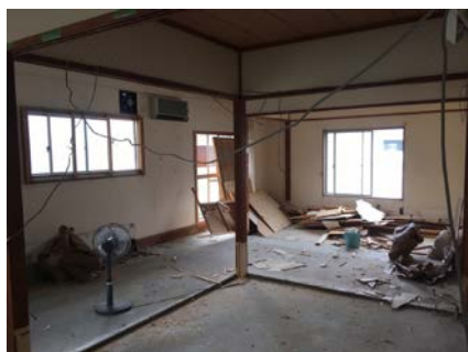
pic4. 小上がり解体中
