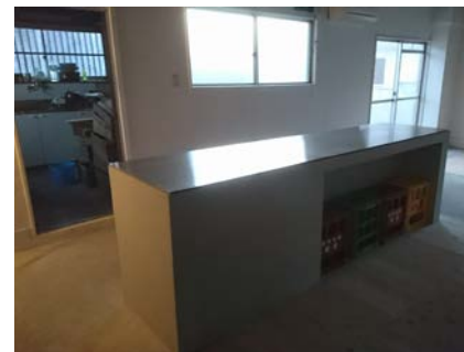
pic6. コーヒーカウンター完成
