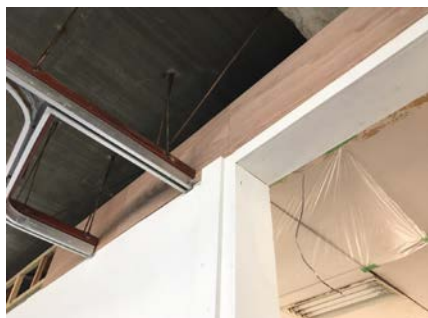
pic7.天井裏を隠す目隠し壁
