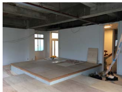
pic3. 小上がり完成後
