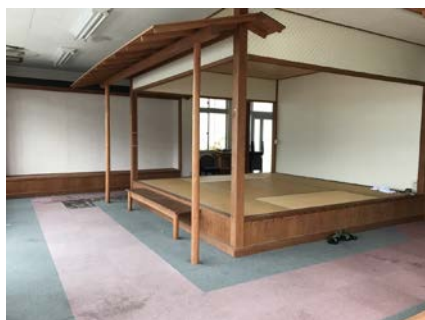
pic1. 小上がり解体前
