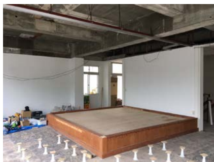
pic2. 新設床の基礎施工
