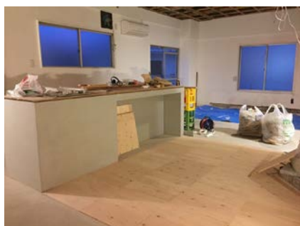
pic8.30mm の凹を埋めた床
