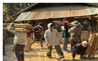
図5 民家の改修作業はかなり大がかりだったが、全員で協力して完遂した。
