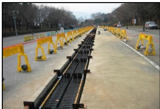
図 8 KAIST OLEV プロジェクト[5] （道路に埋め込む作業）
