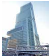
「あべのハルカス」省エネルギー・省CO2設備工事
