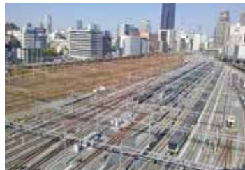
品川駅改良軌道工事
