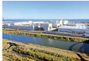
東北地方最大の下水処理施設「南蒲生浄化センター」
