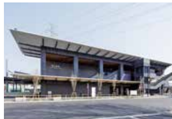
JR 青梅線東中神駅橋上化工事
