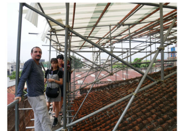
図4 セブの屋根修復現場
