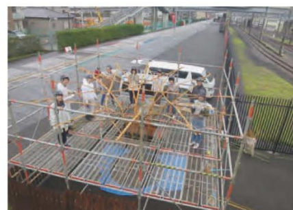
竹製街具の組立作業
